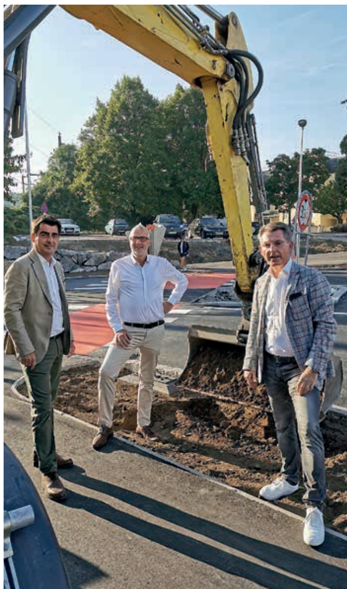
Update Kreisverkehr Donaustraße: BGM Christian Gepp, Wolfgang Schenk (Leitung Bauamt) und STR Hubert Holzer informieren über die straßenbaulichen Verbesserungen.
