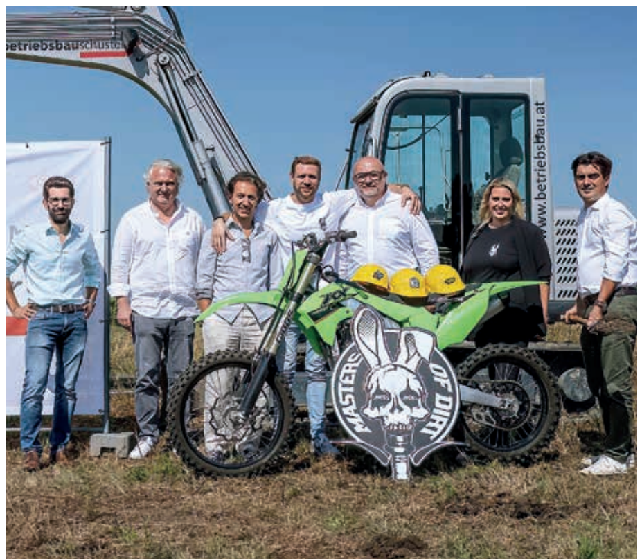
Spatenstich: Christoph Schuster, Alexander Fend, Wolfgang Vanek, Georg Fechter, Bernd Mösslacher, Martina Meisterl und BGM Christian Gepp beim Spatenstich.
