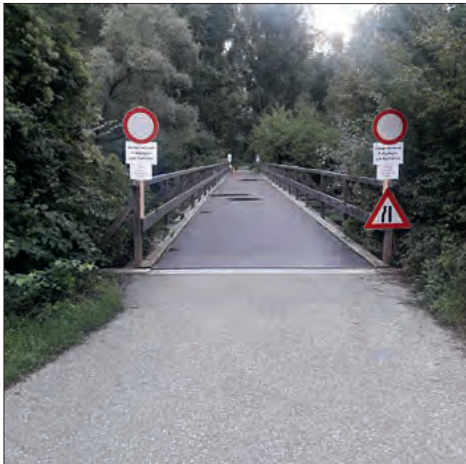
Die Hofaubrücke konnte mit Platten ausreichend saniert werden, um für den Fuß- und Radverkehr wieder nutzbar zu sein.
