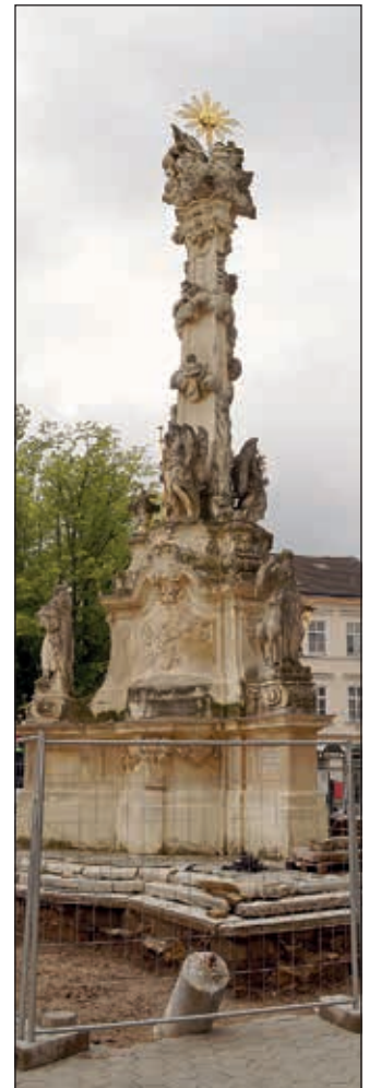
Die Dreifaltigkeitssäule wird derzeit saniert und für die Zukunft fit gemacht.
