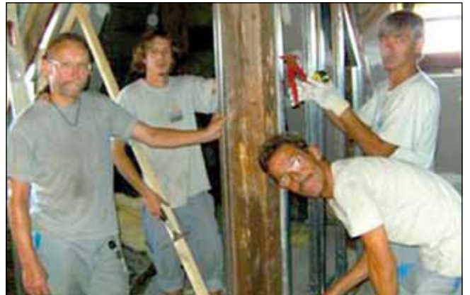
Am Dachboden des Rathauses wird zügig gearbeitet.
