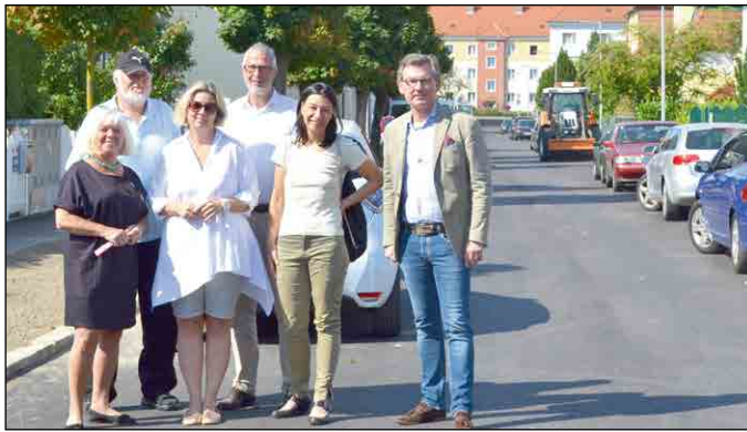
Bauamtsdirektor Wolfgang Schenk und Baustadtrat Hubert Holzer präsentieren GR Johann Pirgmayr, GR Traude Wobornik, GR Karin Schuster-Zwischenberger und StR Elisabeth Kerschbaum die sanierte Straße.
