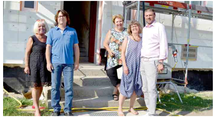
Vizebürgermeisterin Helene Fuchs-Moser inspizierte mit GR Traude Wobornik, Thomas Öller, GR Elisabeth Springer und StR Martin Peterl den Fortschritt der Sanierung.
