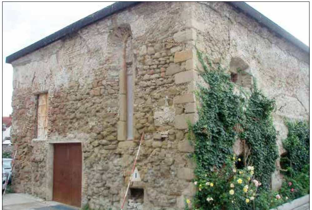
Die Rossmühle in der Rossmühlgasse dient heute als Garage und Lagerraum.
